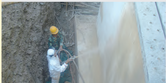
Покрывание бетонных фундаментов
