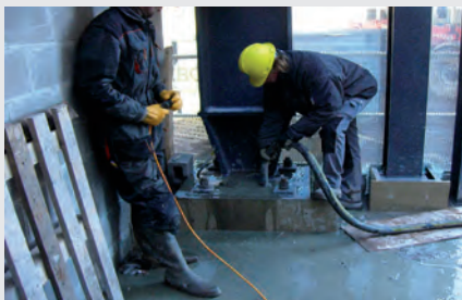
Заполнение стальных колонн
