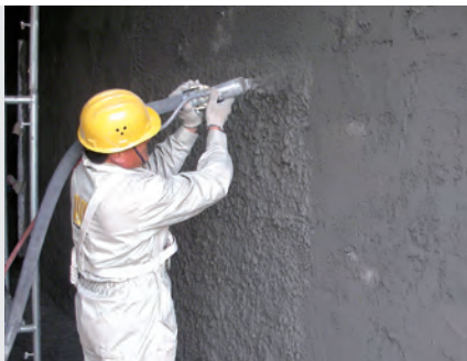
Внутренние штукатурные работы
