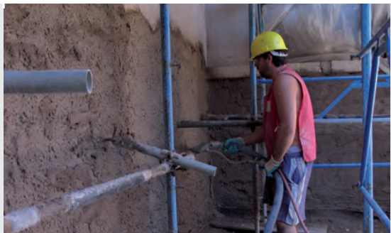
Наружные штукатурные работы
